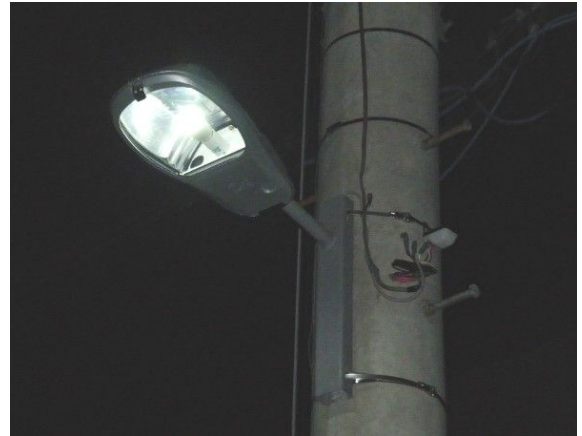
電柱に取り付けたところ
